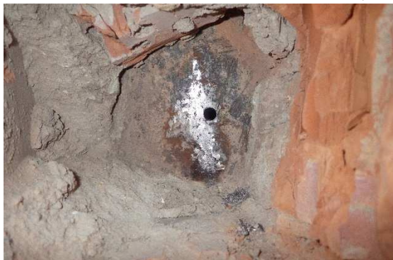
Foto č.53;54--sonda NS-C5-přiblížení, obnažená část;
