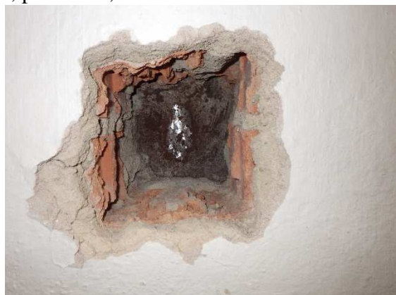
Foto č.23--sonda NS-B1 –obnažená část; Foto č.24--sonda NS-B2 –celkový pohled
