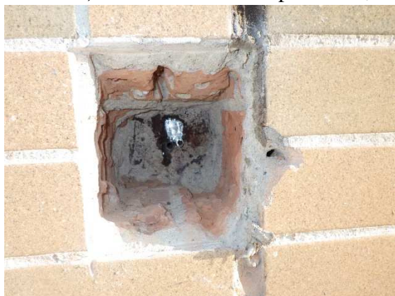
Foto č.15;16--sonda NS-A7 --celkový pohled, detail obnažené části;
