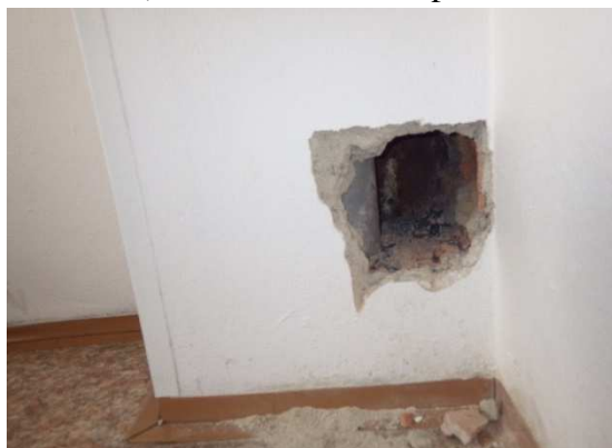
Foto č.47;48--sonda NS-C2-přiblížení, obnažená část;
